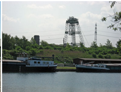
Blick vom Sportplatz Bleckenstedt über den Kanal zum Schacht KONRAD II
